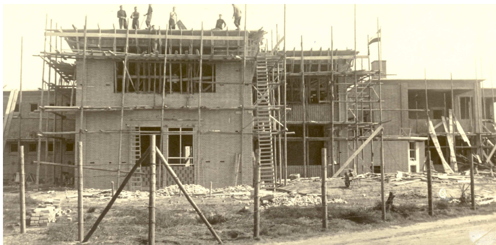
Kouvenaarschool in aanbouw
