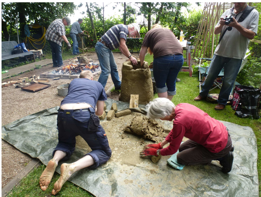
Volop activiteit op de bouwplaats.
