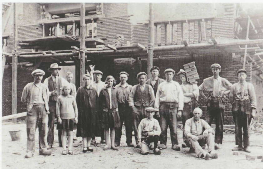
Bouwoakkers van het bedrijf van R. van der Wijk uit Heerenveen, die de kerk herbouwden.
