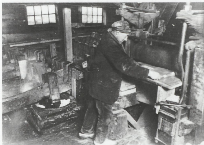
1911 – Interieur van de papiermolen Holthuizen van Lucas Dijkgraaf op de Grift, met natpers en hamerbakken. (Met dank aan Gemeentearchief Apeldoorn)
