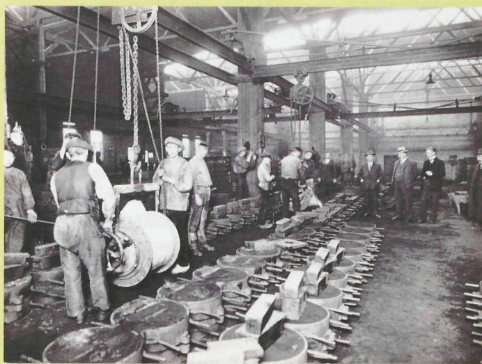
Gietwerk uit de gietpan in de vormen voor Vulcanus-remblokken, 1925
