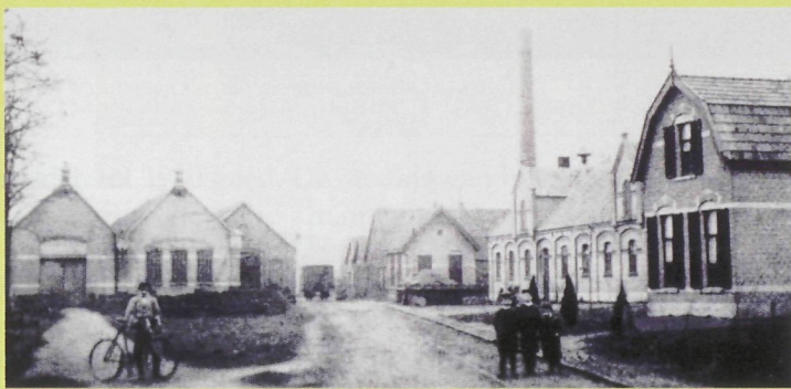
Links de ijzergieterij, rechts de staniolfabriek, 1906
