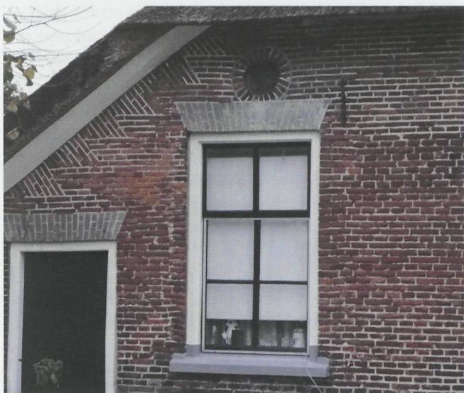
Dit raam zou al bij de bouw geplaatst zijn.
