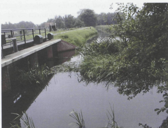
Inlaat van de Grift in het Kanaal
