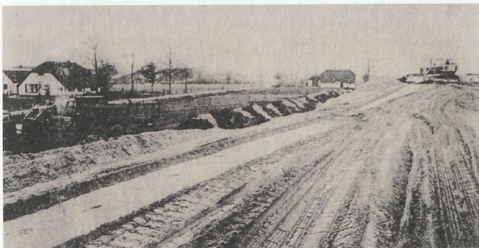
Aanleg van de Rijksweg 50 en de S.9, met links de Spiekerweg. Hier zien we de bulldozer aan het werk, bijna ter hoogte van de Brink. Links vooraan staat het huisje van de familie Dokter. Eertijds zaten we hier in de berm bij het jaarlijkse ringrijden tijdens het Zuukerfeest. Een vertrouwde wereld was voorgoed voorbij.
