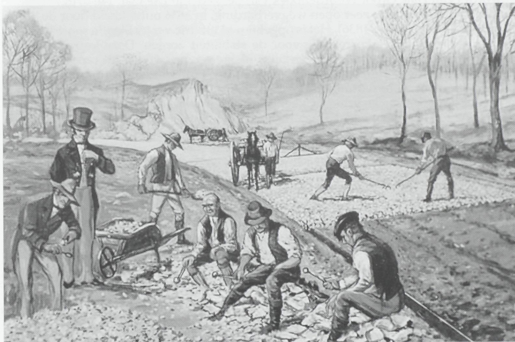
Aanleg van een macadamweg ten tijde van John Loudon McAdam (1823). Het schilderij is van Carl Rakeman.
