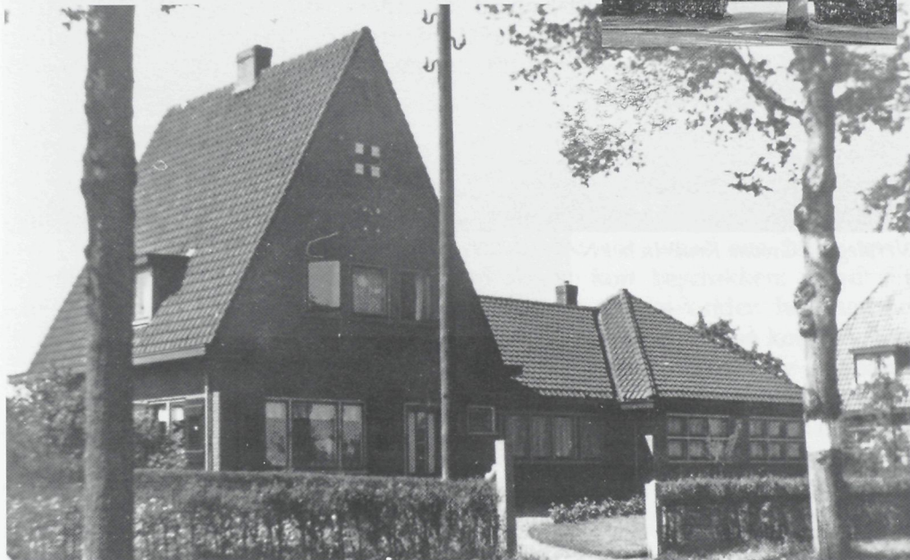
Het Groene Kruisgebouw aan de Prins Hendrikweg in Vaassen
