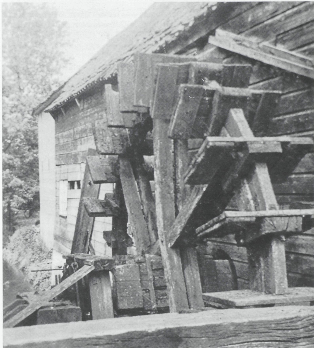
Het onderslagrad van de in 1938 afgebroken Grijtsemolen (foto: Willem Terwel)
