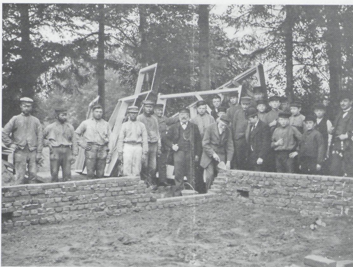
Eerste steenlegging door Tiemen Hooiberg
