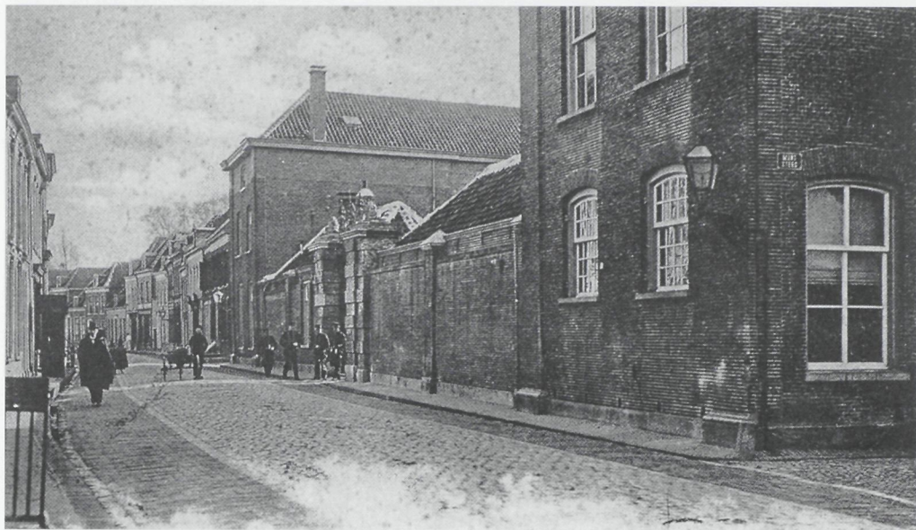
Koloniaal Werfdepot aan de Smeepoortstraat te Harderwijk
