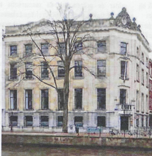
Het kantoor van de NHM, Herengracht 466, Amsterdam
