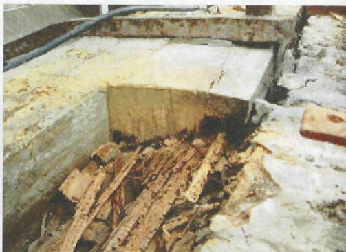
Rotte balk met anker
