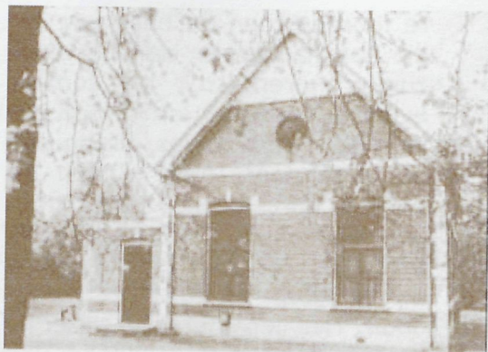
De Brei- en Naaischool (de voorloper van de Nijverheidsschool voor meisjes) in het Weertspark te Epe, gebouwd in 1908 met hulp van ds. Prins.
