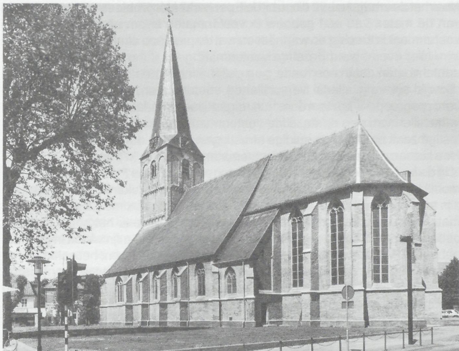
Overzicht van de kerk vanuit het zuidoosten. Foto archief RDMZ, A.J. van der Wal, mei 1994
