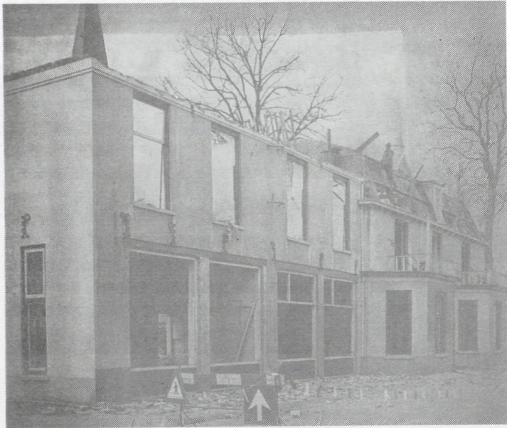
Hotel-restaurant De Cannenburgh in 1970; de afbraak is begonnen.
