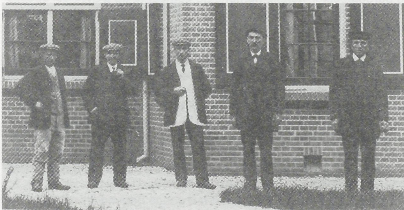
Na de voltooiing van het gebouw werden de bouwers gefotografeerd. Van links naar rechts: Joh. Kwakkel, Van Lohuizen of Lammers of Witteveen, W. van Vemde (de latere (hulp)koster van de Ned Herv. kerk), de gebroeders Joh. en G. ter Haar.
