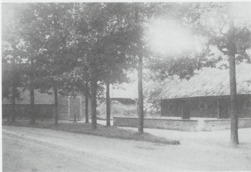
Westgevel gezien vanuit het zuidwesten.
